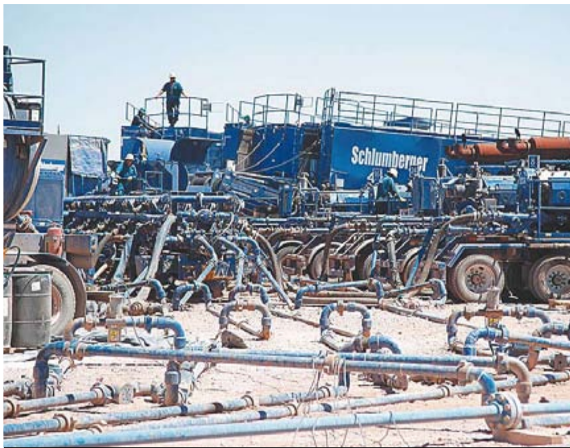
Tracción - Vaca Muerta se destaca por sí mismo y por el impacto sobre proveedores industriales, de servicios y de construcción.
