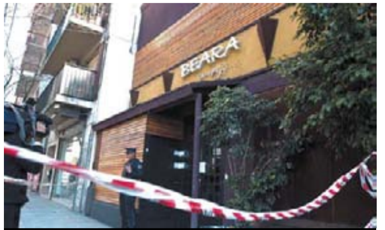
Derrumbe - Cuando el boliche colapsó, Farrell era director de Habilitaciones.
