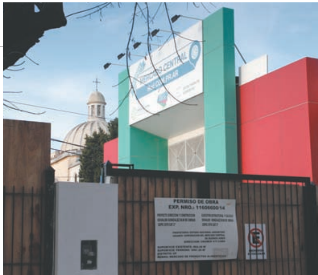
El predio de la calle Cramer, entre Newbery y Lacroze, tiene las obras avanzadas aunque paralizadas ahora.
