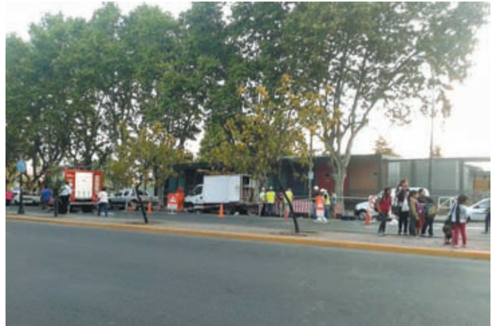
El escape de gas obligó a cerrar la circulación en Almirante Brown al 300, frente a Casa Amarilla.
