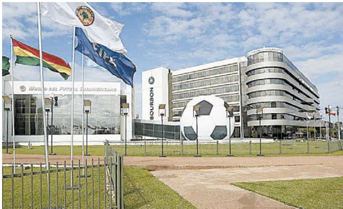
El edificio de la Conmebol, en Luque. Después del FIFA-gate, la credibilidad de los dirigentes quedó por el piso.
