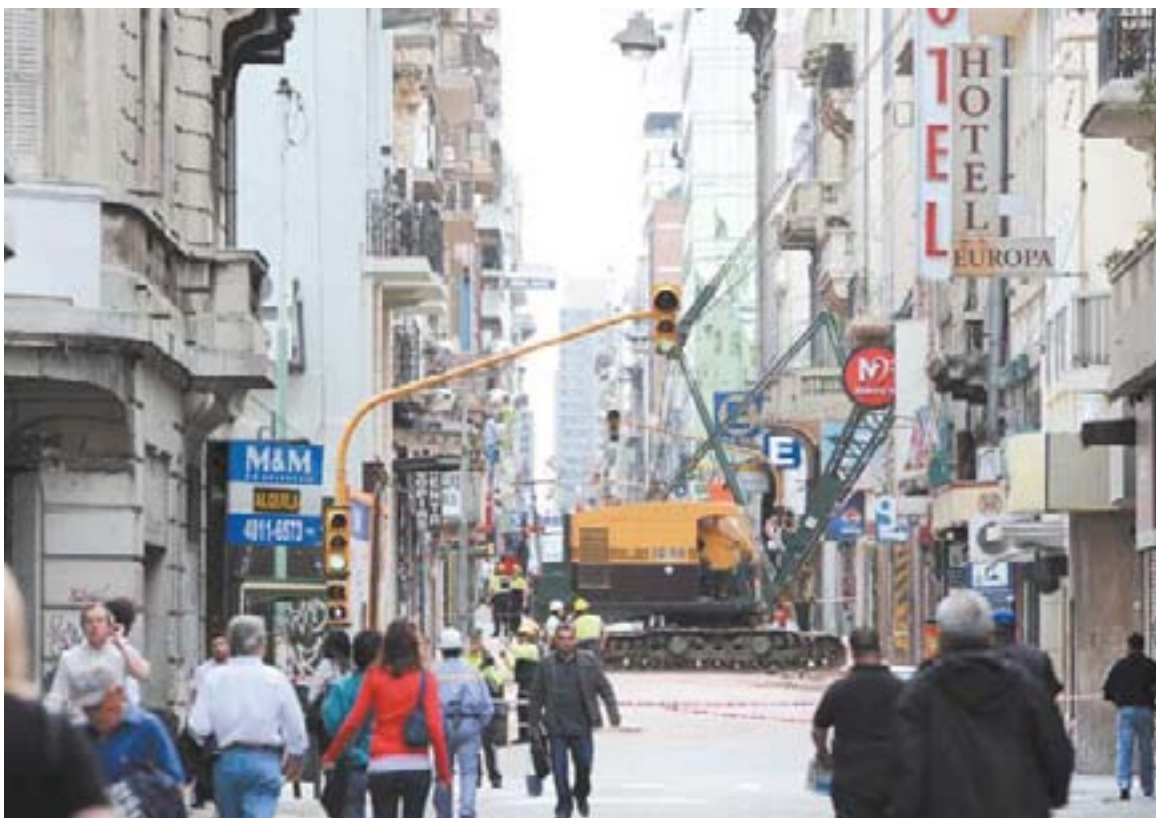
Colapso - Ayer se retomaron las tareas de demolición, que habían sido suspendidas para buscar a Isidoro Madueña.
