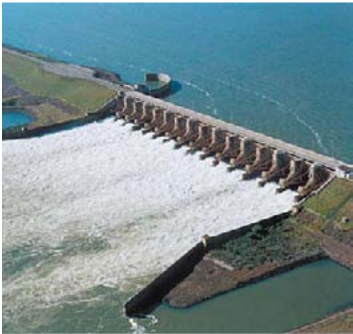
Vista - Sin problemas en sus turbinas, dijo un comunicado oficial.
