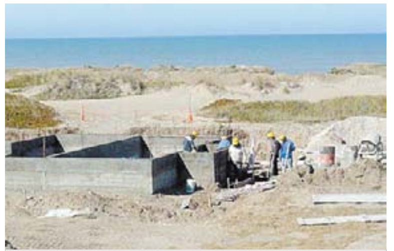
Ladrillos - Con la cercanía del verano, la constructora aceleró las tareas.
